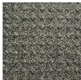
■スロープタイルの凹凸面状
